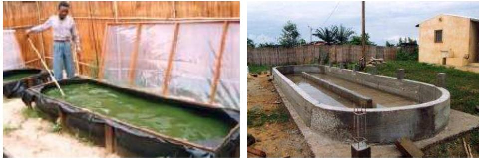
Figure 6a (à gauche) et 6b : La photo de gauche montre un bassin en bois-plastique de 7m<sup>2</sup>, installé à Pahou (Bénin) ; l'homme est en train d'agiter le milieu de culture de spiruline, à l'aide d'un balai. Sur la photo de droite, c'est un bassin en béton de 33 m<sup>2</sup>, en cours de construction. Sa largeur est de 3 m, ce qui rendra l'agitation manuelle possible. © TECHNAP/CREDESA 2001.
